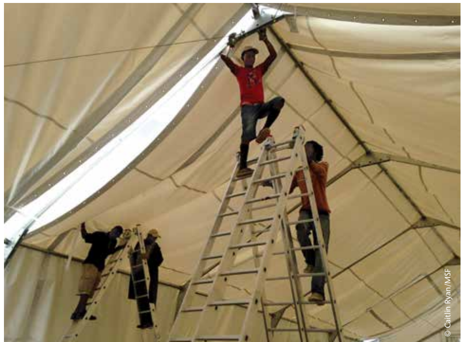
Des ouvriers construisent ce qui deviendra une des salles d'ELWA 3, le centre de traitement Ebola de MSF en périphérie de Monrovia.
