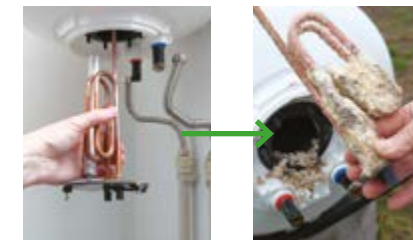
TERMOPLÁSTICO resistencia en contacto directo con el agua (generalmente más barato)
