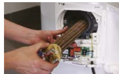
ESTEATITA sin contacto directo con el agua -> resistencia en un manguito
