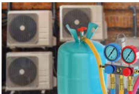
Vérification de la pression du gaz
